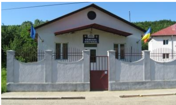
Căminul Cultural din Gura Calitei după lucrările de modernizare (Foto C. Bălan anul 2010)
