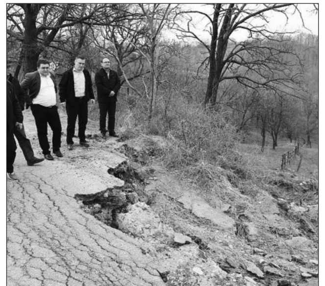
De-a lungul vremii, firma Euro Proiect a câștigat mai multe licitații pentru proiectarea unor lucrări de reparații a drumurilor din județ
